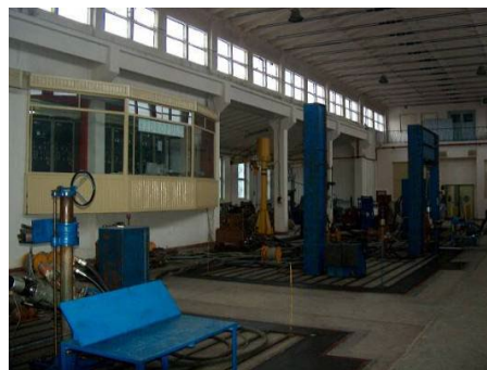
Fig.11 - Camera de comandă a instalației de tip Hidropuls
