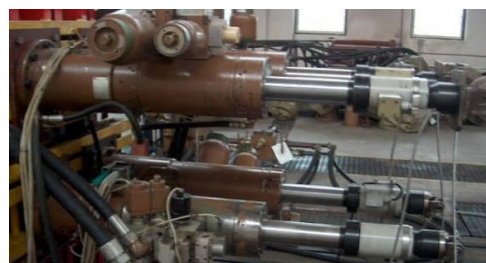
Fig.7 - Cilindri hidraulici, dispuși pentru acționarea pe orizontală
