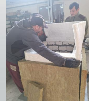
Montaj izolatie termica
