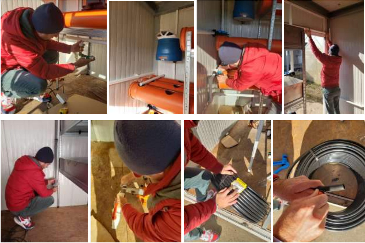
Fig. 2 Aspecte din timpul execuției unor repere ale demonstratorului experimental
