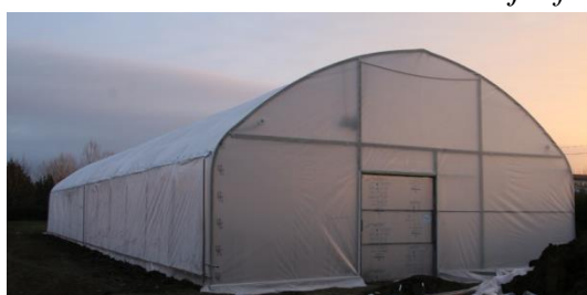
e. solarul cu pereți verticali gotic finalizat
