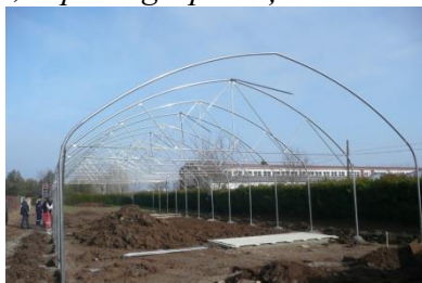
b. montajul structurii metalice
