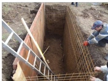
a. realizarea căminelor de acces din beton armat
