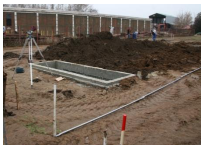
a. marcarea terenului, săpatul gropilor și turnarea cuzinețelor de beton
