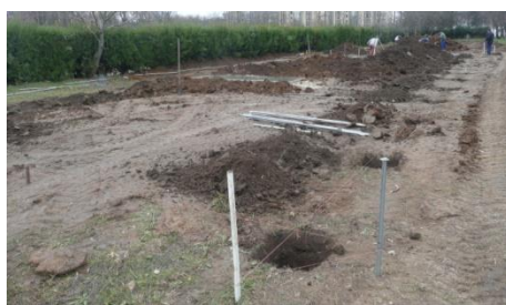
a. marcarea terenului, săpatul gropilor și turnarea cuzinețelor de beton
