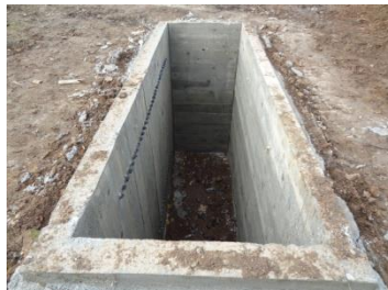
a. realizarea căminelor de acces din beton armat
