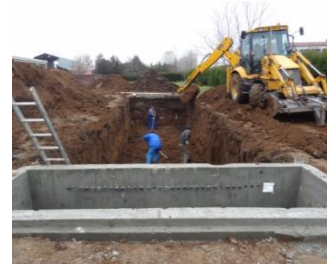
b. excavare pământ
