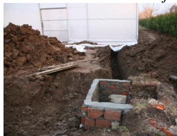
d. realizare rețea de alimentare cu apă
