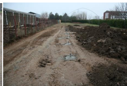
a. marcarea terenului, săpatul gropilor și turnarea cuzinețelor de beton
