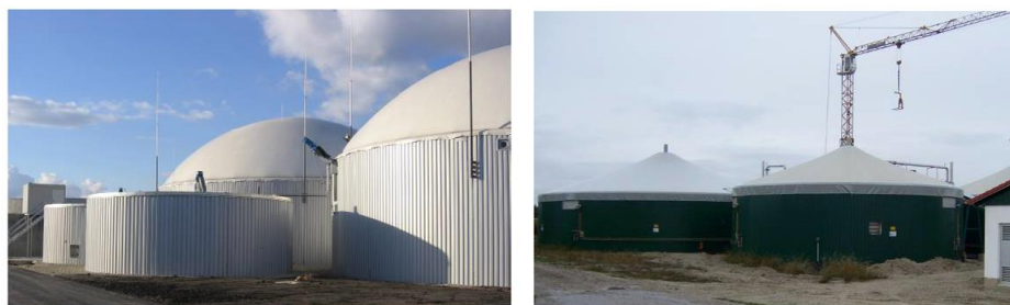
Fig. 2. Digestoare verticale, acoperite cu membrane impermeabile pentru gaze (Schafer W, Lehto M, Tey F, 2009) - stânga și (RUTZ, 2006) – dreapta
