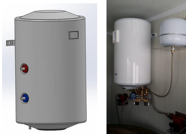
Fig. 27. Boiler electric al instalației MGA
