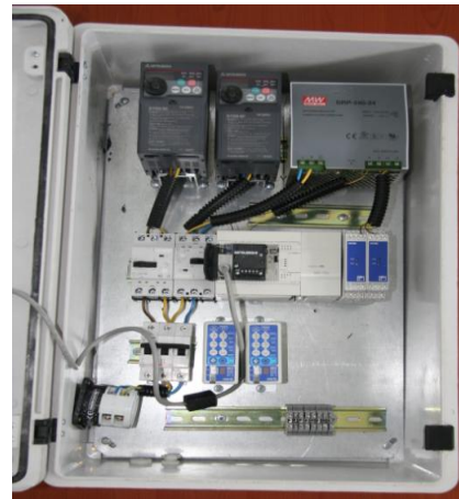
c) Tablou instalație de automatizare
